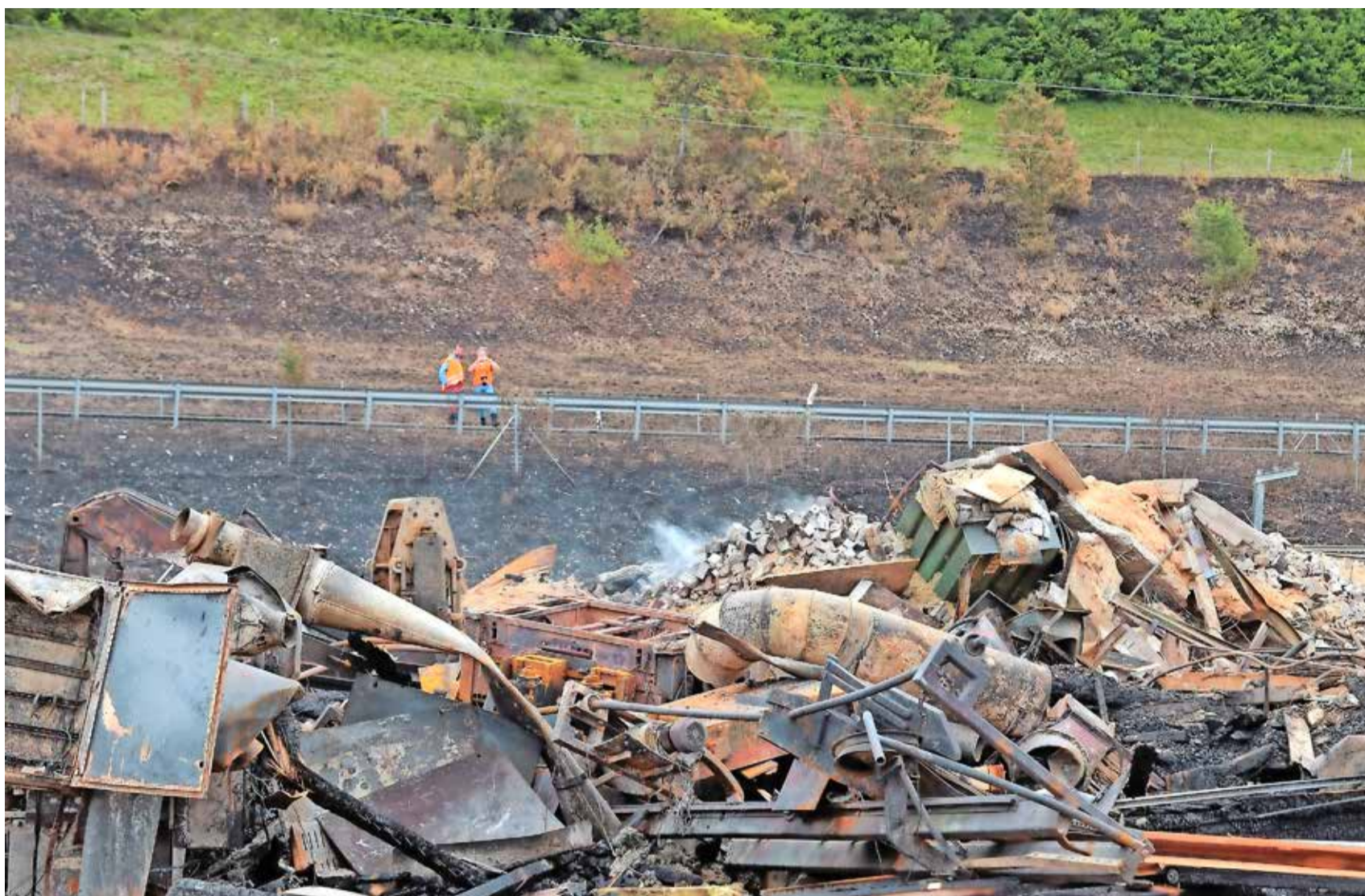
Bei dem Grossfeuer brannte nicht nur die Sägerei in Merishausen vollständig nieder, auch Maschinen und Werkzeuge wurden völlig zerstört.
